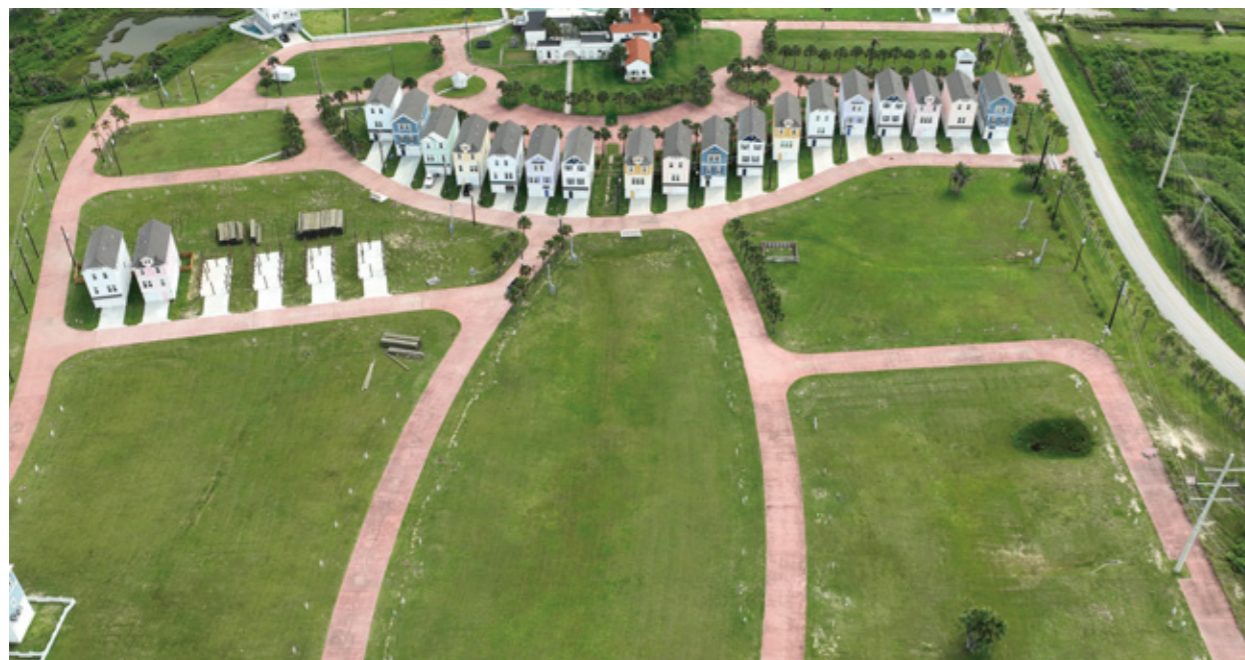
项目图集一 加尔维斯顿实景拍摄
