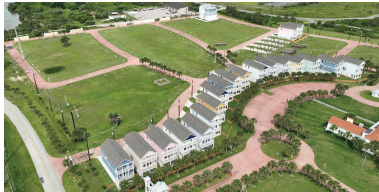
项目图集一 加尔维斯顿实景拍摄
